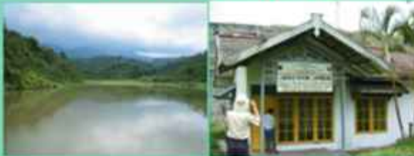
Waduk dan Power-house PLTM Kalijari
