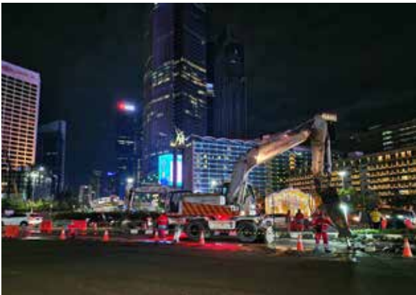
Perbaikan Jalan Bundaran HI
